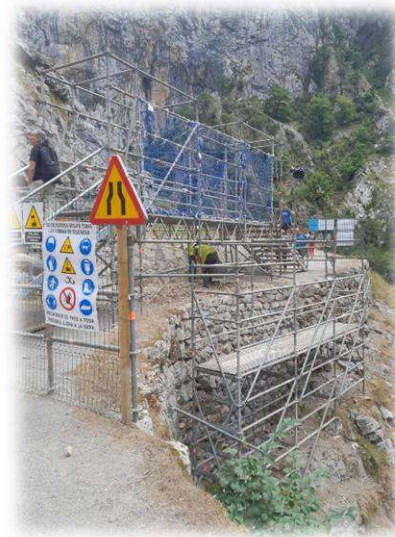
Ilustración 25: Plataforma provisional para paso peatonal durante las obras en la ruta
