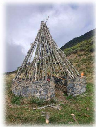
Ilustración 29: Reparación de chozo ganadero. Pista de Pandetrave a Valcabao
