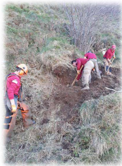
Ilustración 10: Cuadrilla de Tragsa y personal del Parque en trabajos de mantenimiento de la vereda de La Sotín. León.
