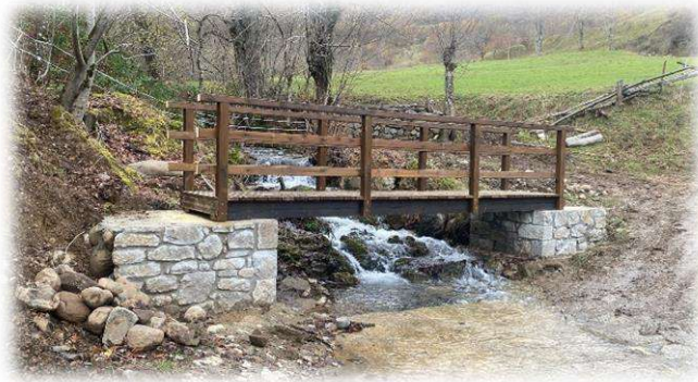
Ilustración 26: Pasarela Rijoles (León)
