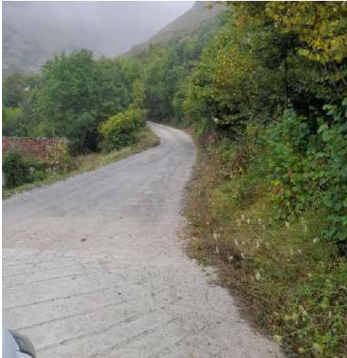
Ilustración 28: Reparación de la pista de Pandébano (Cabrales)
