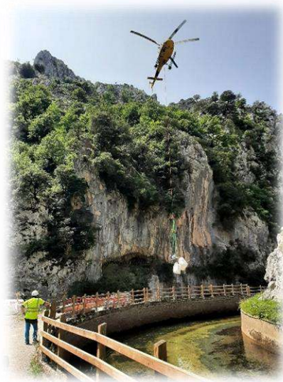
Ilustración 24: Reparación de muro en la ruta del Cares (León)
